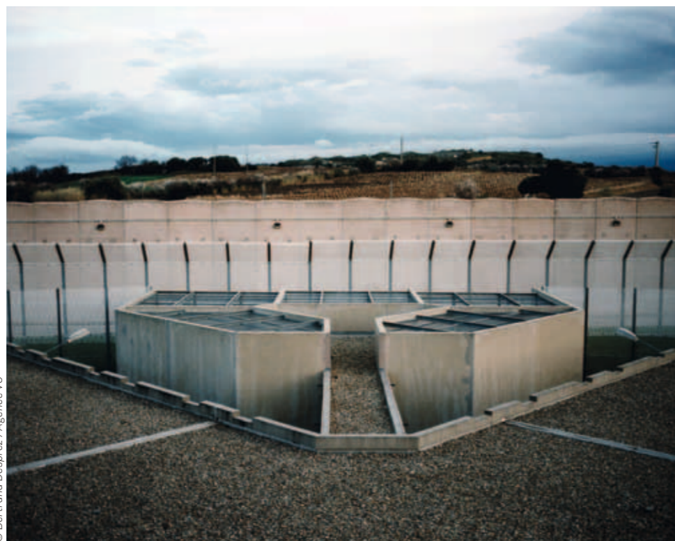
Centre pénitentiaire de Perpignan, 1999.
